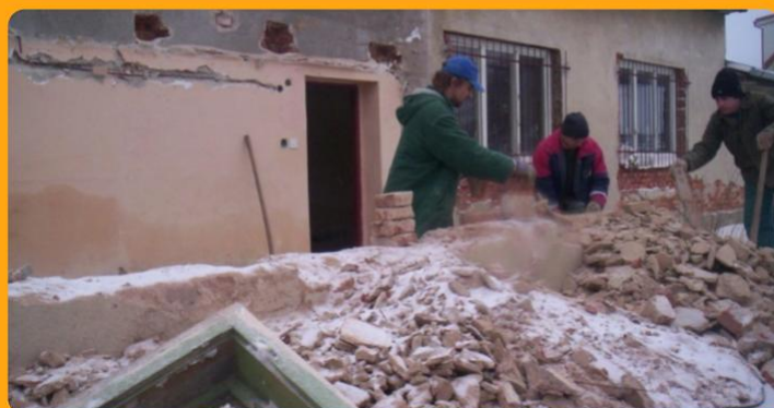
Oprava budovy - Nádražní 362, Pacov
